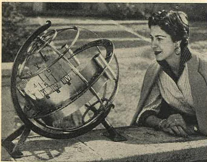
Abbildung 1: Äquatorialsonnenuhr, von L. M. Loske, mit einer Einteilung für die Stunden der „wahren Sonnenzeit“ und der Normalzeit.
